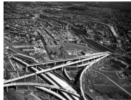
Construction de l'échangeur Turcot. 1966.
